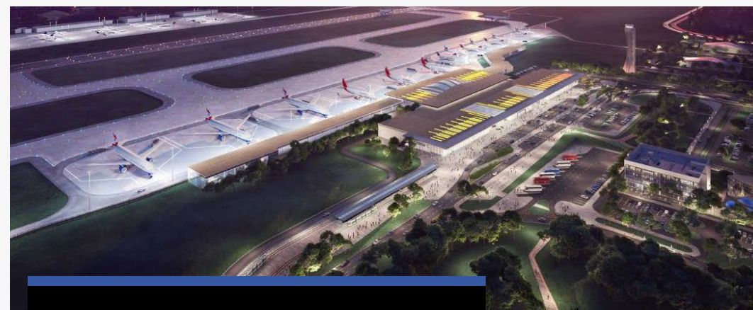
Infraestructura aeroportuaria Aeropuerto Internacional El Dorado II fase I y II del Plan Maestro.
